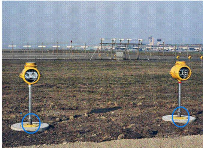
**Figura 2-6-4. Ejemplos de Cuplas Frangibles montaje de tubos en luces de aproximación**
