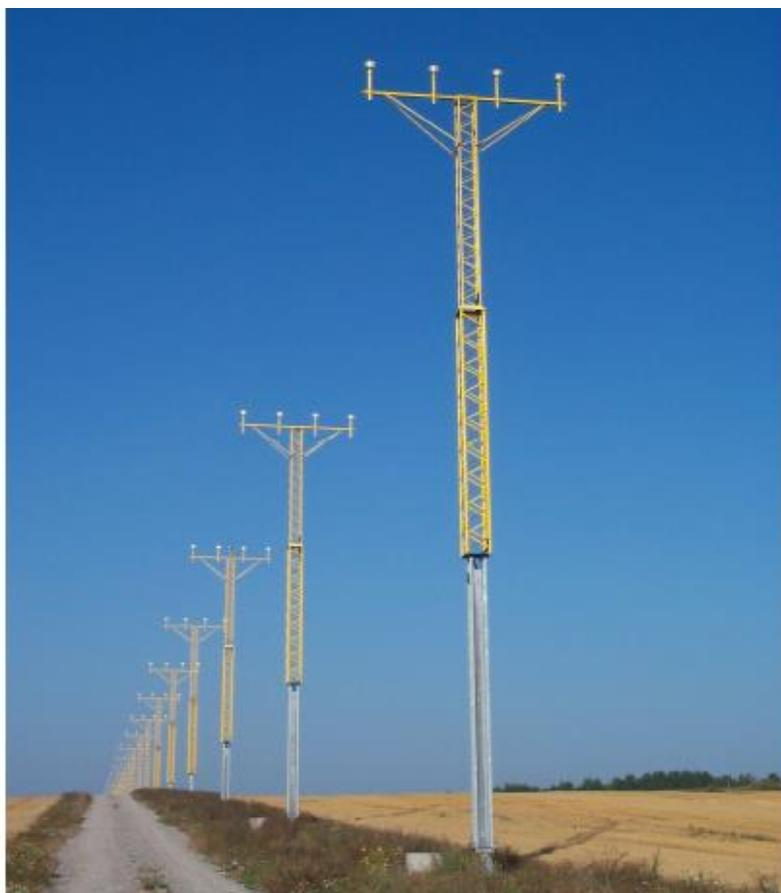
**Figura 2-8-1. Torres de iluminación de aproximación de fibra de vidrio sobre estructuras de soporte rígidas**
