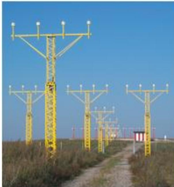
**Figura 2-8-2. Torres de iluminación de aproximación de fibra de vidrio**
