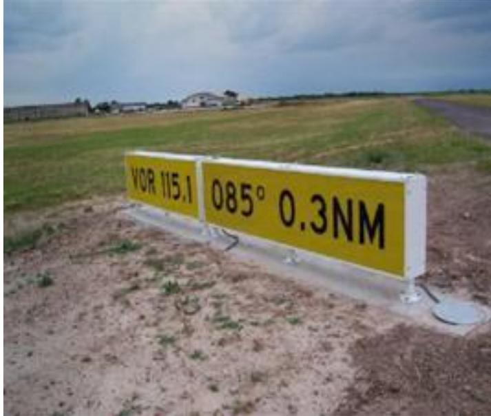
Figura 2-4-2. Letrero de punto de verificación del VOR en el aeródromo
