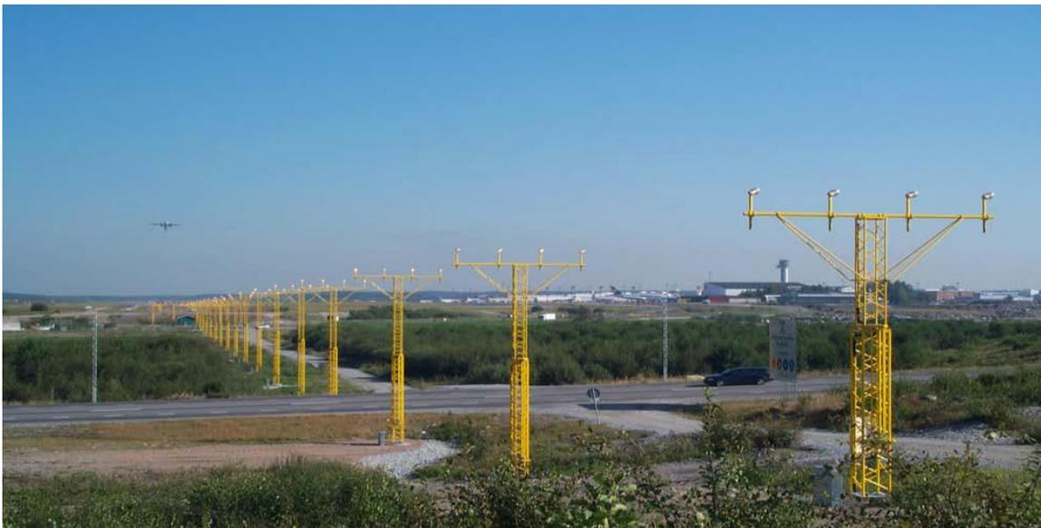
**Figura 2-6-2. Torres de iluminación de aproximación — Estructuras reticulares de fibra de vidrio**
